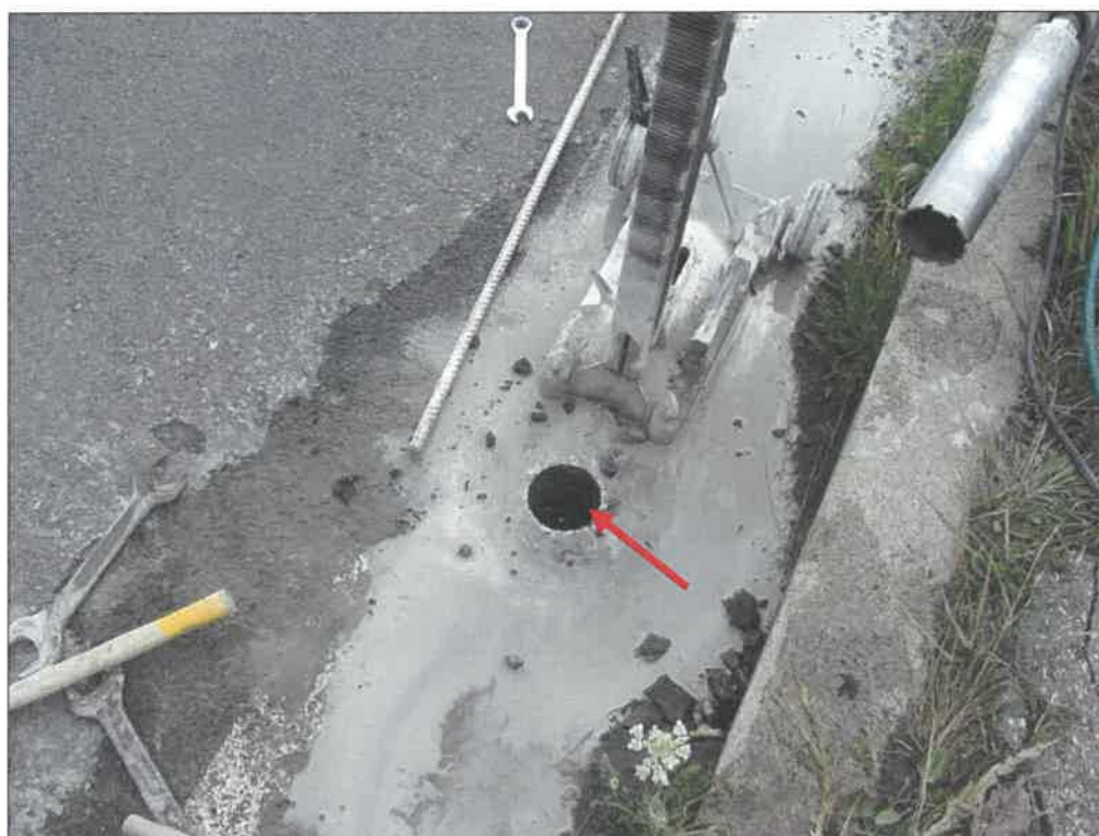
Foto 6: Provádění jádrového vrtu pro zjištění souvrství vozovky, vrt V7.
