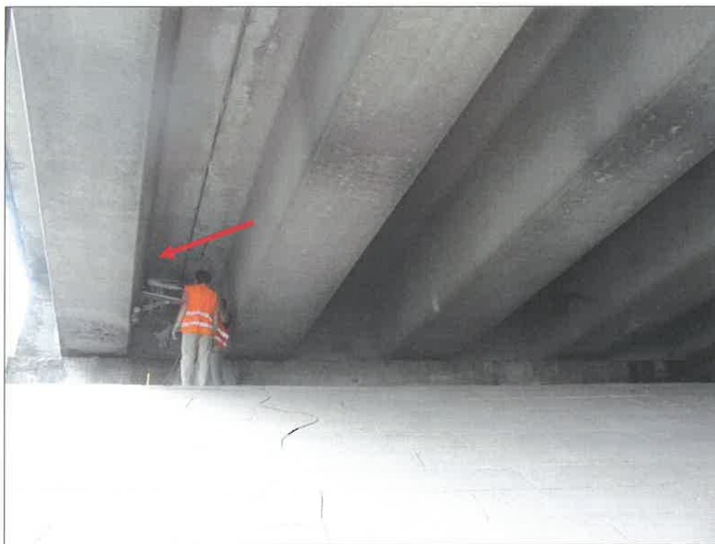
Foto 4: Provádění jádrového vrtu do boku nosníku. Vrt V3.
